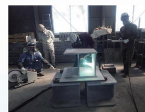
金属溶射の施工では、部材角部の面取りや脱脂などの前処理、プラストによる素地調整、金属溶射 (溶射トーチの操作や施工順序)、封孔処理など様々な工程があります。また、各作業工程では溶射皮膜の品質を確保するためのポイントがあります。
