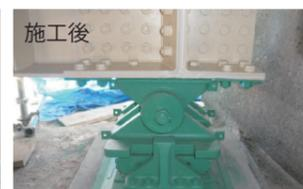
鋼桁端部は、主桁・横桁および支承と橋台立ち上がりコンクリートや耐震補強部材、落橋防止装置等の付属物に囲まれた狭隙部です。従来、狭隙部での施工は、重防食塗装との併用を行ってききましたが、皮膜の耐用年数の違いを考慮し、すべてを金属溶射により施工できるように技術開発を行っています。
