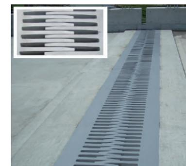
橋梁の多径間連続化に伴い、鋼製伸縮装置の大型化が進み、雨天走行中の車両 (特に二輪車) のスリップ対策として、フェイスプレートの滑り止めが重要になってきました。
